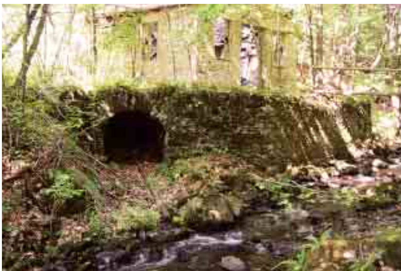
Stará stavba vodnej elektrárne Habeš
