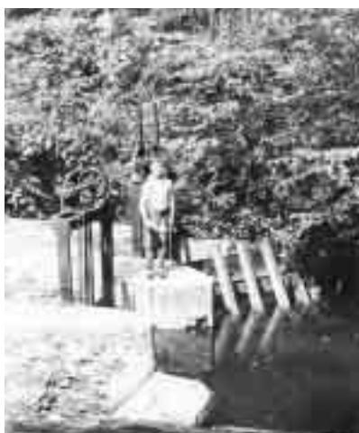
Stavidlo na vodnej elektrárni
